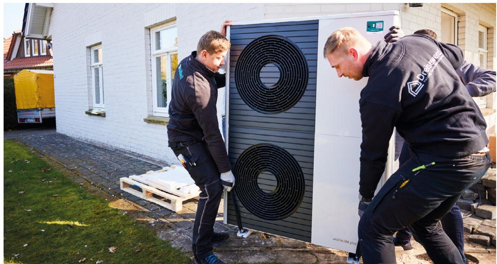
Abb. 10: Aufstellung Außeneinheit, Quelle: Vaillant
